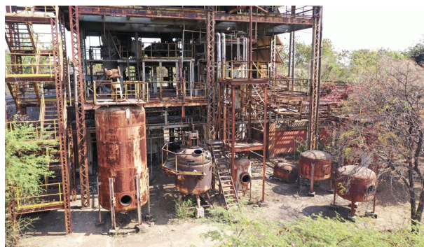
Vue aérienne du site de l'incident de Bhopal en Inde
